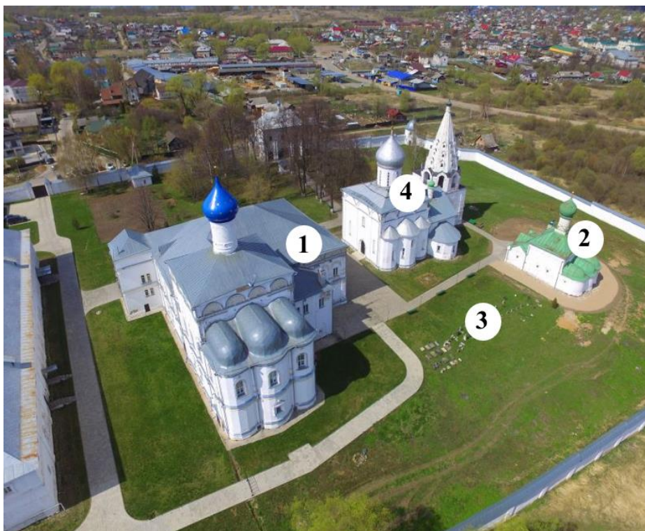
Рисунок 4.23 Территория Свято-Троицкого Данилова монастыря. Цифрами обозначены области исследований: 1 – подвалы здания Церкви Похвалы Божьей Матери и прилегающая территория; 2 – возможные остатки старого фундамента вблизи здания Церкви Всех Святых; 3 – участок территории между зданиями церквей; 4 - Троицкий собор.
