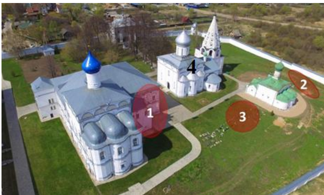
Рисунок 7 – Территория Свято-Троицкого Данилова монастыря. Цифрами на красном фоне обозначены области исследований: 1 – подвалы здания Церкви Похвалы Божьей Матери (ЦПБМ) и прилегающая территория; 2 – возможные остатки старого
