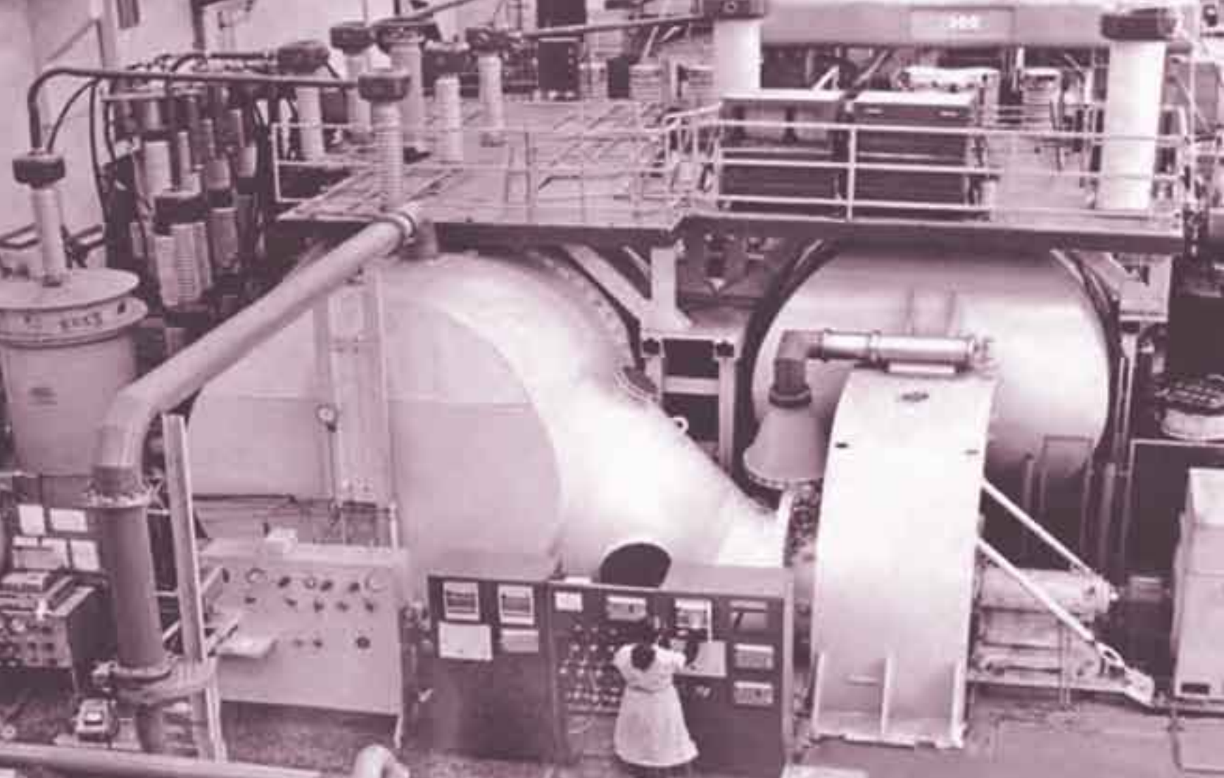
Частотно-импульсный электроионизационный лазер ЗД01.
