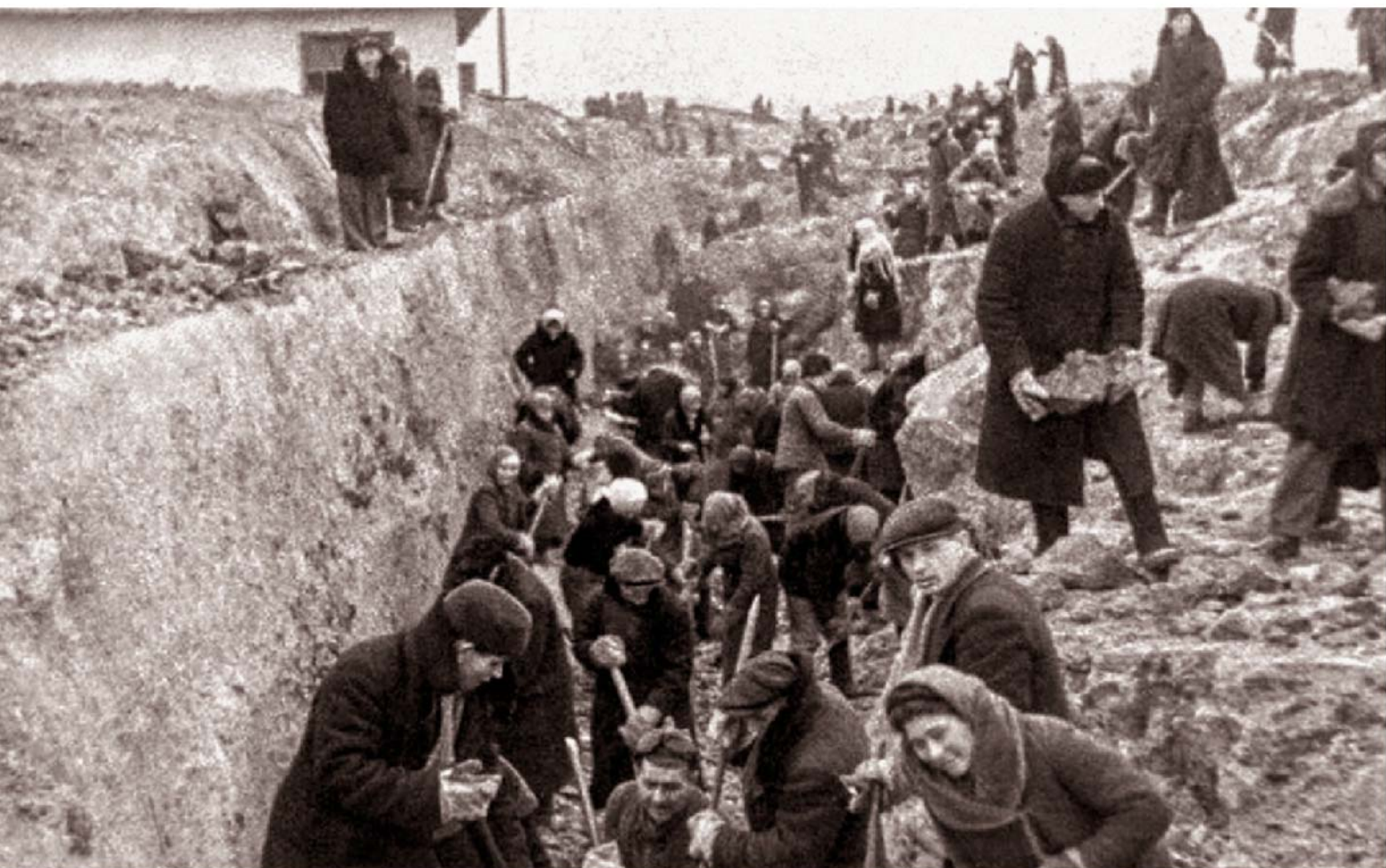
На строительстве Казанского обвода.
