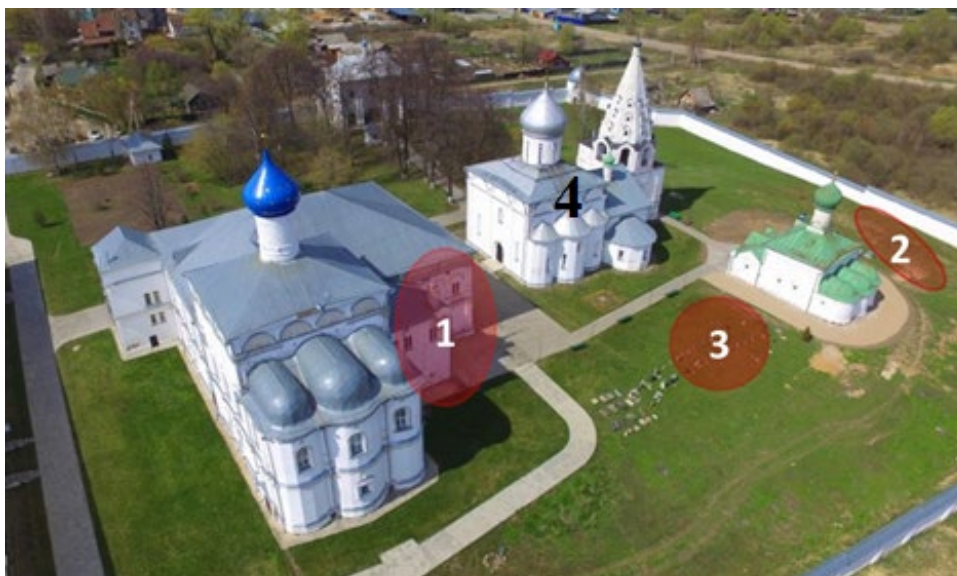
Рисунок 4.1 – Территория Свято-Троицкого Данилова монастыря. Цифрами на красном фоне обозначены области исследований: 1 – подвалы здания Церкви Похвалы Божьей Матери и прилегающая территория; 2 – возможные остатки старого фундамента здания Церкви Всех Святых; 3 – участок территории между зданиями церквей; 4 - Троицкий собор.
